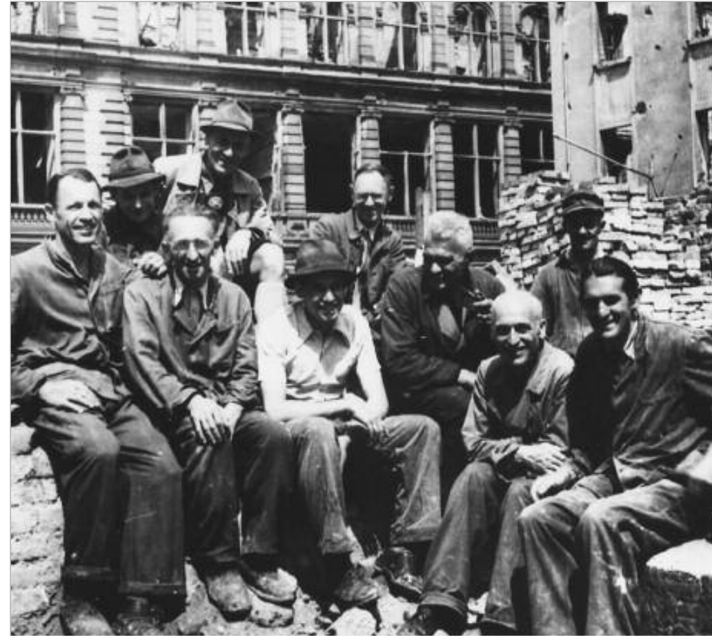
Nach 1945 lagen die Firmensitze in der Löwengrube (München) und in der Neuen Mainzer Straße (Frankfurt) in Trümmern. Bevor es mit den Geschäften weitergehen konnte, mussten die Gebäude wieder aufgebaut werden. Die Mitarbeiter gingen selbst ans Werk, sie räumten Trümmer, Schutt und Asche beiseite. In Frankfurt veräußerte Anne Marie Hauck ihren Familienschmuck und kaufte vom Erlös Eisenträger und anderes Baumaterial. Das Bild zeigt „Trümmerarbeiter“ Walter Hahn (vierter von rechts) und seinen Münchener Bautrupp im Jahr 1945.
