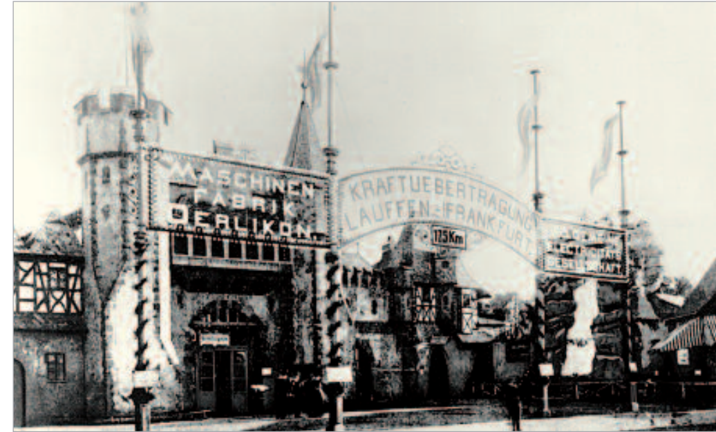
Charles Brown und Walter Boveri, damals noch als Angestellte der Schweizer Firma Oerlikon, errichteten 1891 eine Leitung zur Fernübertragung von elektrischem Strom zur Internationalen Elektrotechnischen Ausstellung nach Frankfurt am Main. Georg Hauck & Sohn war über einen langen Zeitraum eine der Hauptbankverbindungen der Mannheimer Konzerntochter von Brown, Boveri & Cie. Internationale Elektrotechnische Ausstellung, Frankfurt 1891.
