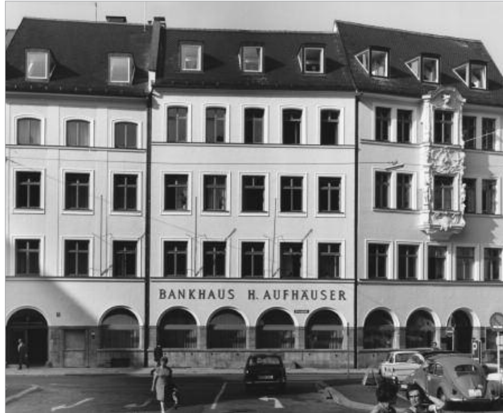
1960 übernahm eine jüngere Generation und begann, das Geschäftsmodell der Bank zu erweitern: Kredit- und Außenhandelsgeschäft wurden zu neuen Ertragsquellen entwickelt. Wiederaufgebautes Domizil des Bankhauses in der Löwengrube, um 1960.
