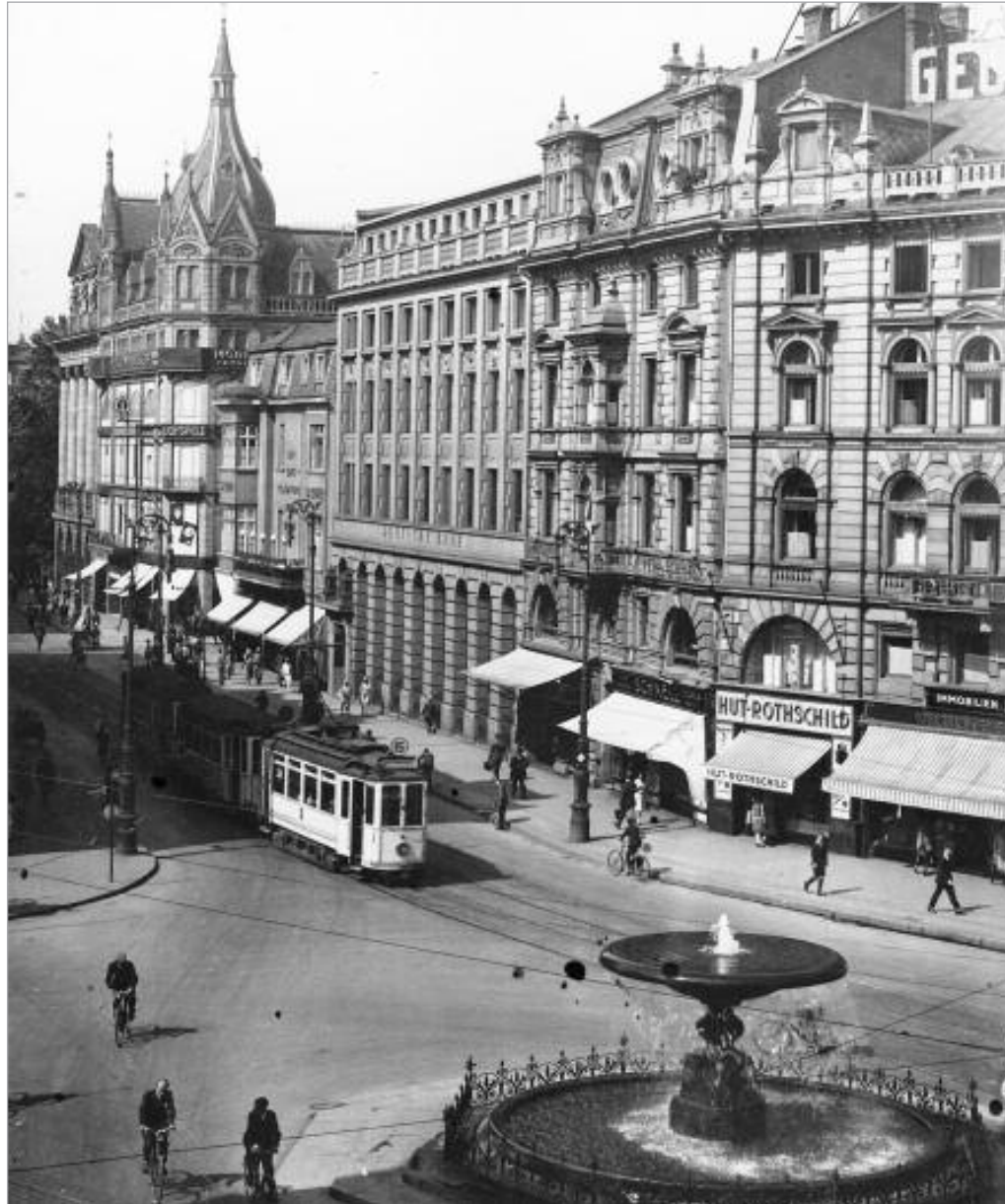
Der Kaiserplatz in Frankfurt am Main um 1930. Der Brunnen wurde 1876 nach dem Vorbild des Lucae-Brunnens auf dem Opernplatz gestaltet und von dem Bankier Raphael von Erlanger gestiftet. Das Gebäude Kaiserstraße 24 – gegenüber der Straßenbahn – war damals eine Niederlassung der Deutschen Bank; heute beherbergt es den Hauptsitz von Hauck & Aufhäuser Privatbankiers.
